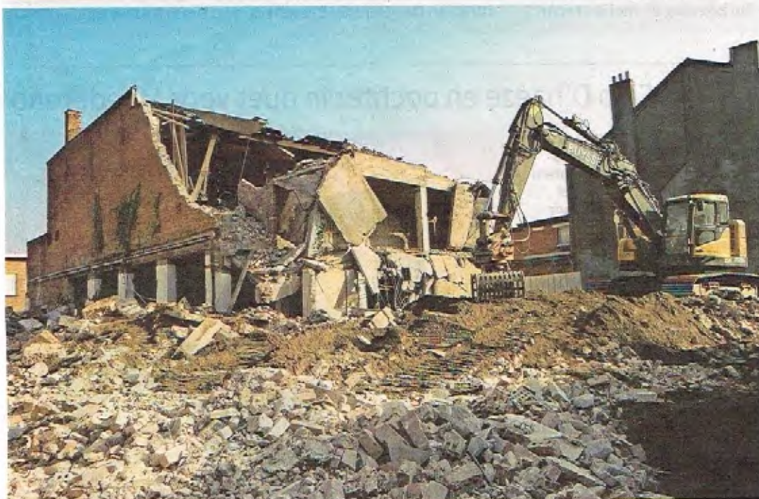
De oude GB gaat tegen de grond en maakt plaats voor een appartementsgebouw. Foto JSA
