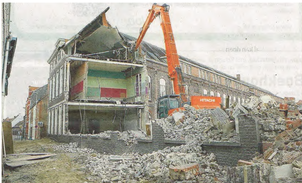
De gebouwen van de vroegere meisjesschool van De Meidoorn gaan tegen de grond. Foto Moens
